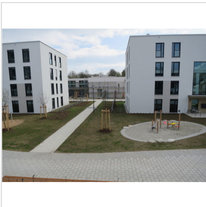
Balkon - Blick nach Süden
